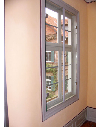
Energetische Verbesserung des Bestandsfensters durch den Umbau zum Kastenfenster
